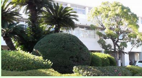
校舎正面を飾るスケールの大きな 生け垣（県立西宮高）
